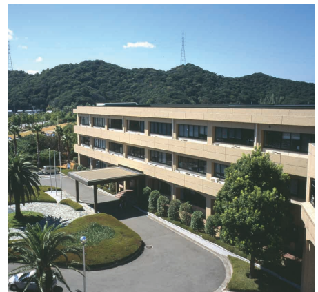
本部棟 Administration Hall
